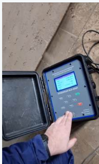
Теплопроводканал, Московская область
