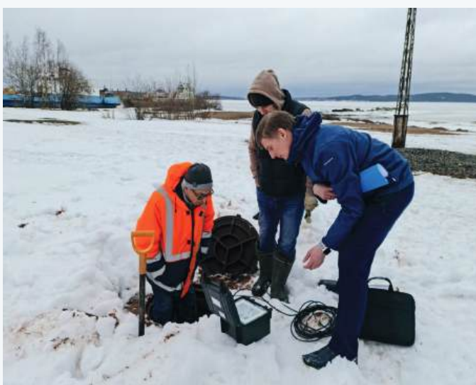
Коллекторы ливневой канализации, г. Петрозаводск
